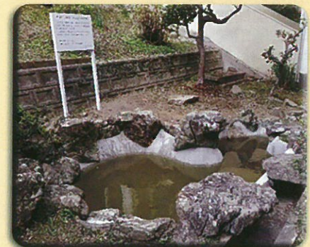
ビオトープの補修(西海市立大瀬戸小学校)
